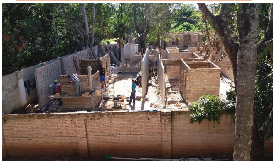
CONSTRUCCIÓN DEL 3ER BLOQUE COMPLEJO "NTRA. SRA. DE BETHARRAM"
